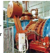
EKN vlinderklep met valgewicht- aandrijving, DN 1200, als veiligheidsafsluiter
