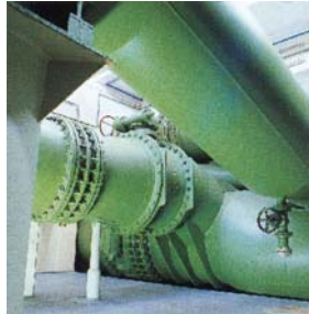
ODS EKN vlinder- klep in een koel- watercentrale
